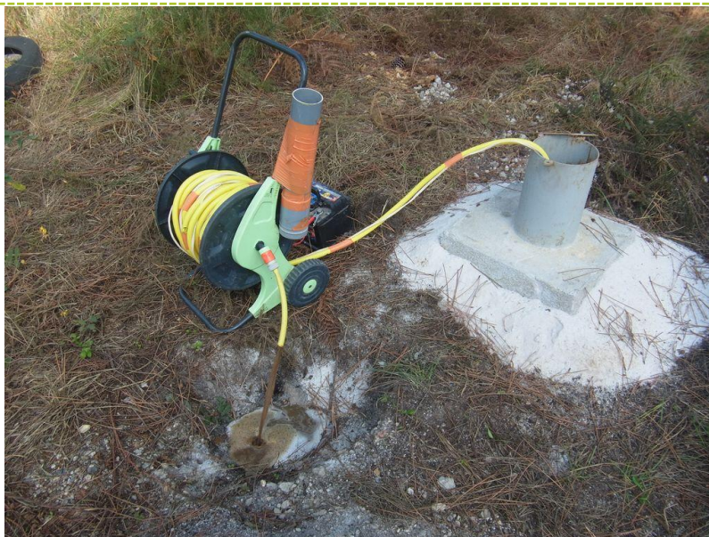
Figure 3 : Piézomètre amont (Pz5) réhabilité (octobre 2014)
